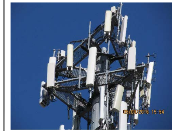
SITE PHOTO 2 SCALE: N.T.S. 3
