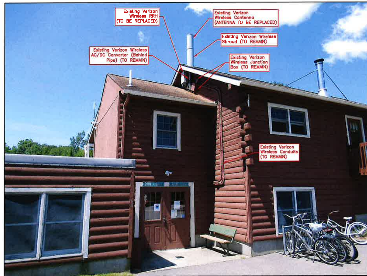
SITE PHOTO 1 SCALE: N.T.S.
