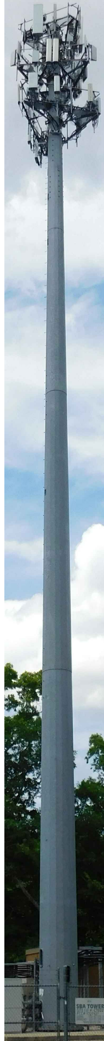
EXISTING TOWER PHOTO 1 SCALE: N.T.S. A-2
