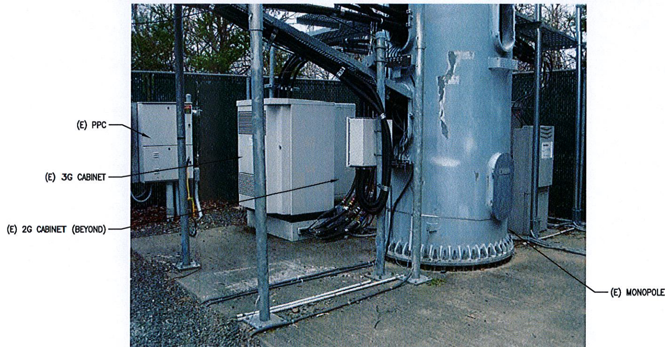
4 EXISTING EQUIPMENT AREA SCALE: N.T.S.
