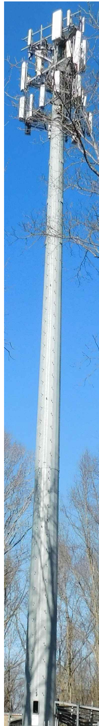
EXISTING TOWER PHOTO SCALE: N.T.S.
