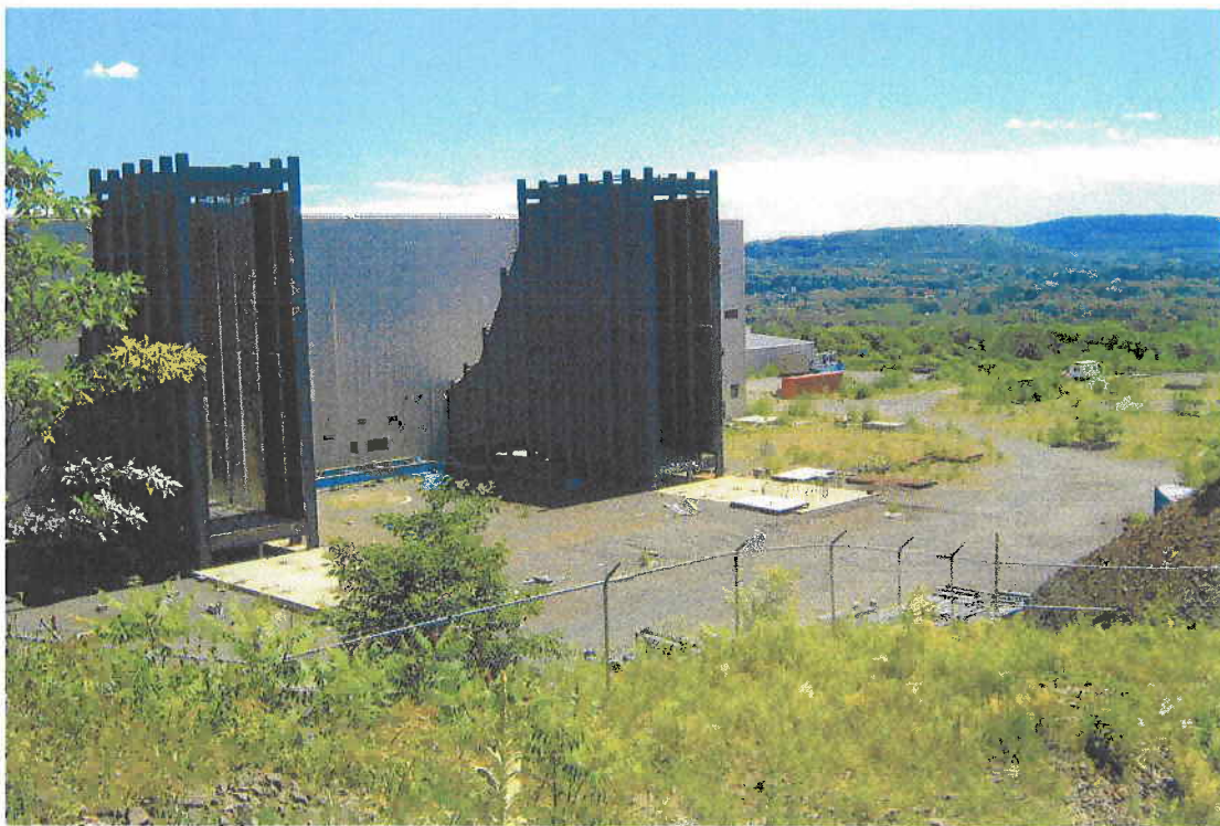
Existing HRSG Foundations and Shells
