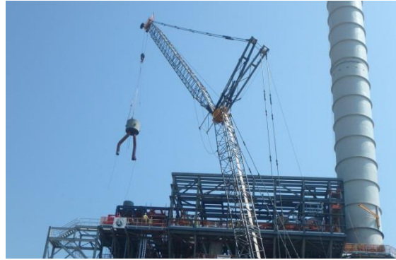
Setting HRSG Silencer
