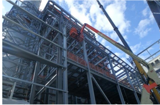
2 nd Level HRSG Pipe Rack Steel Erection
