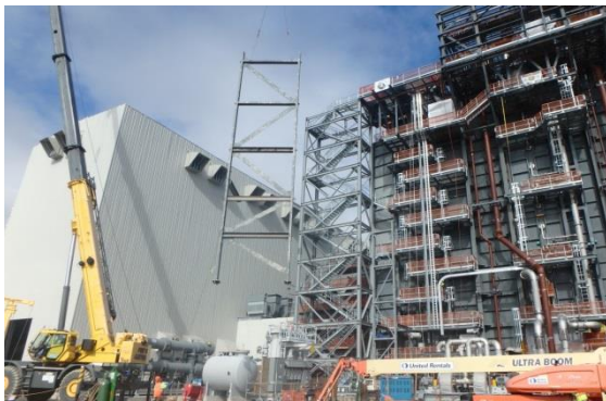
HRSG Acoustic Wall Erection
