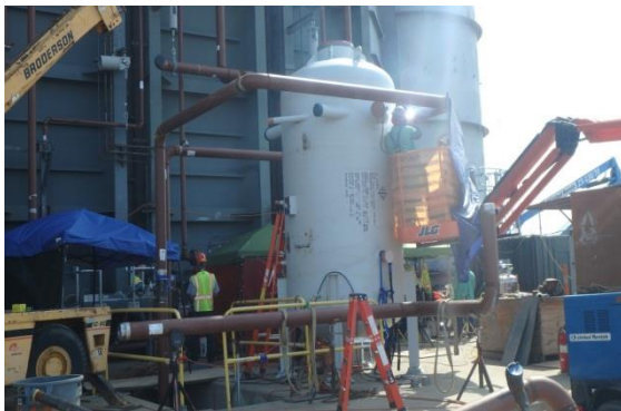
Installing Drains to the HRSG Blowdown Tank
