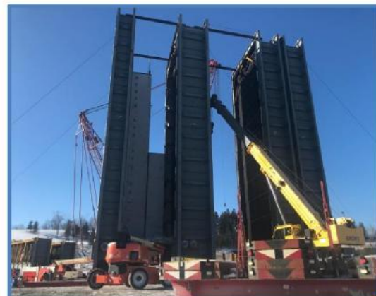
HRSG Fabrication at Coeymans
