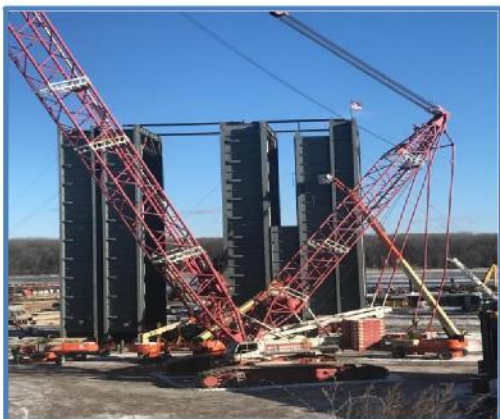
HRSG Fabrication at Coeymans
