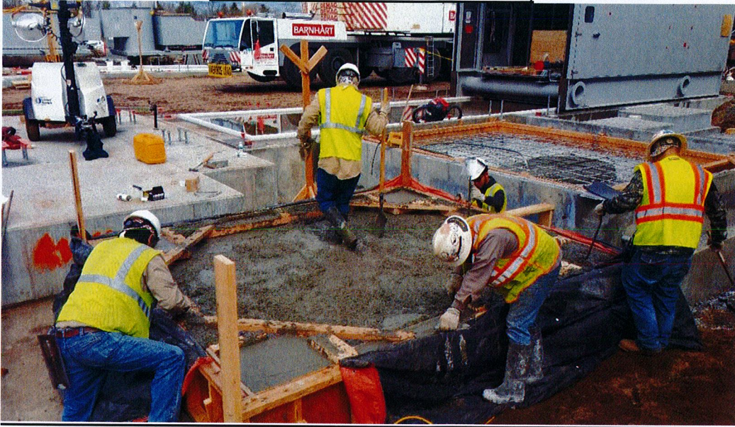
Poured concrete for Fin fan cooler,
