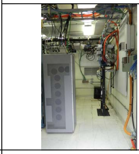
SITE PHOTO 2 SCALE: N.T.S. 3
