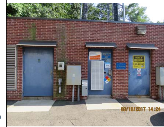
SITE PHOTO 2 SCALE: N.T.S. 3
