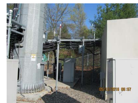
SITE PHOTO 2 SCALE: N.T.S. 3
