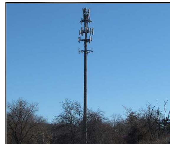
SITE PHOTO 1 SCALE: N.T.S. 2
