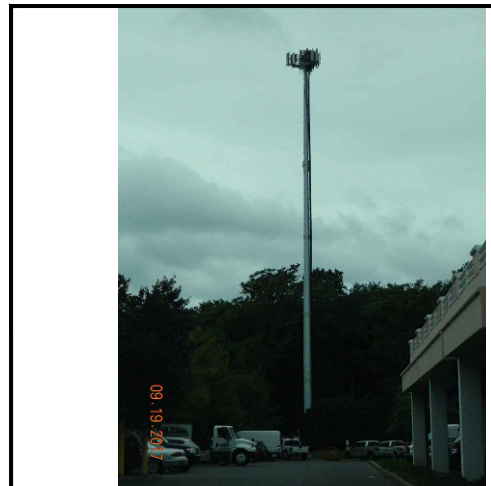
SITE PHOTO 1 SCALE: N.T.S. 2
