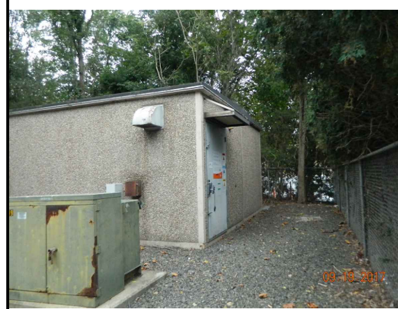
SITE PHOTO 2 SCALE: N.T.S. 3
