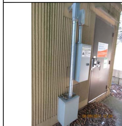
SITE PHOTO 2 SCALE: N.T.S. 3
