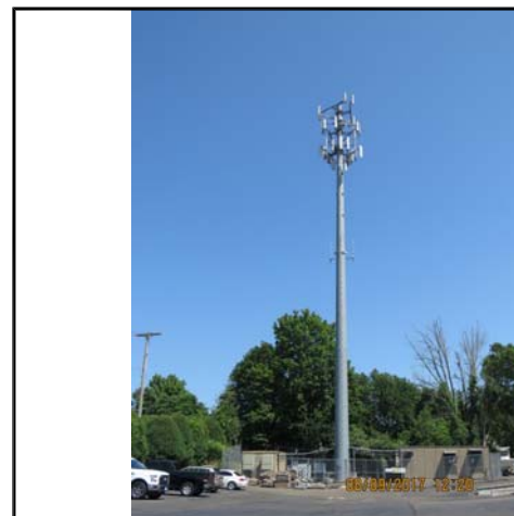
SITE PHOTO 1 SCALE: N.T.S. 2
