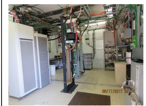
SITE PHOTO 2 SCALE: N.T.S. 3
