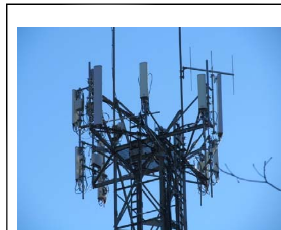
SITE PHOTO 1 SCALE: N.T.S. 2
