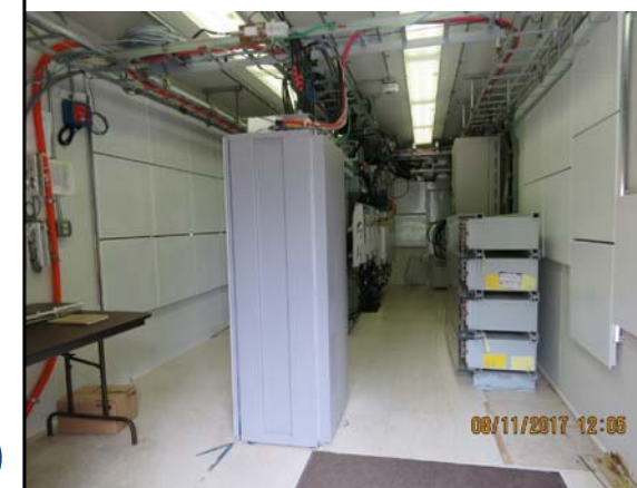
SITE PHOTO 2 SCALE: N.T.S. 3
