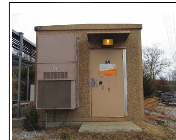
SITE PHOTO 1 SCALE: N.T.S. 2
