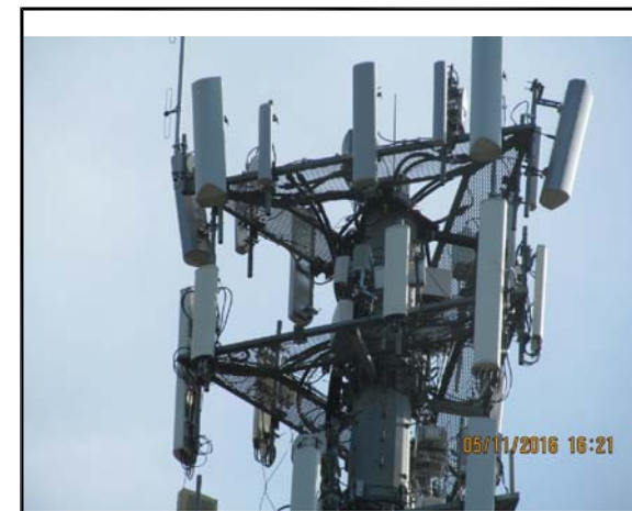
SITE PHOTO 1 SCALE: N.T.S. 2
