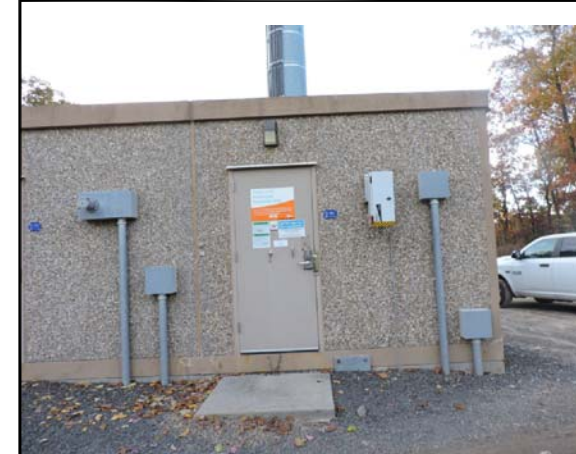
SITE PHOTO 2 SCALE: N.T.S. 3
