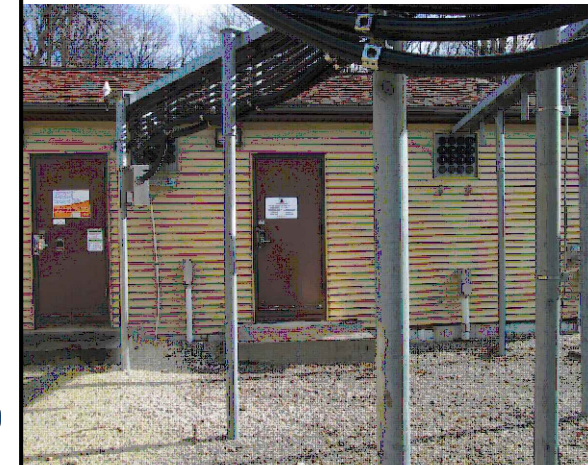
SITE PHOTO 2 SCALE: N.T.S. 3
