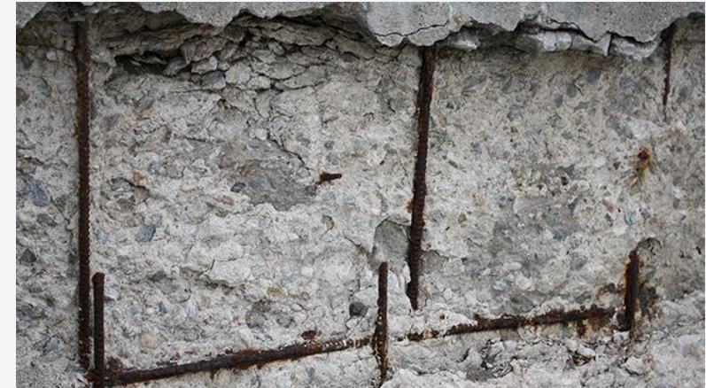
Spalling
