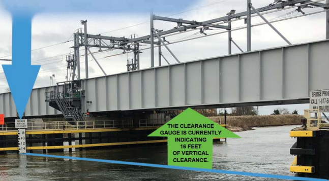
CALADO DE AIRE = DISTANCIA DESDE LA LÍNEA DE FLOTACIÓN HASTA EL PUNTO MÁS ALTO DE LA EMBARCACIÓN
