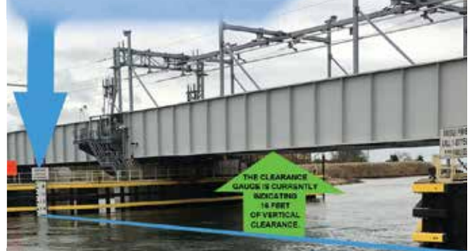
CALADO DE AIRE = DISTANCIA DESDE LA LÍNEA DE FLOTACIÓN HASTA EL PUNTO MÁS ALTO DE LA EMBARCACIÓN
