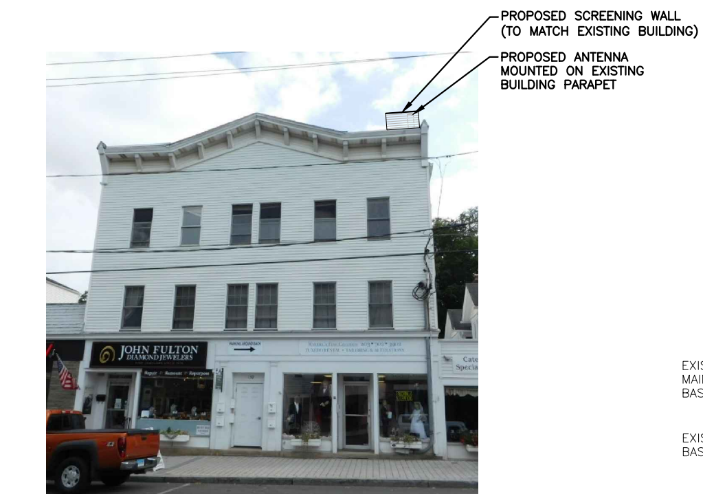
EXISTING CONDITIONS PHOTO DETAIL SCALE: N.T.S.
