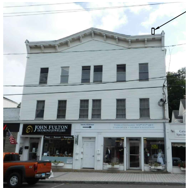
EXISTING CONDITIONS PHOTO DETAIL SCALE: N.T.S. 2 A-1
