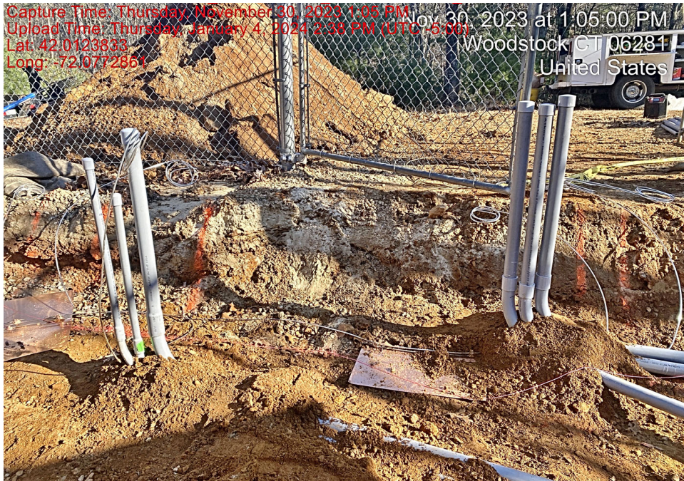
New conduit installation
