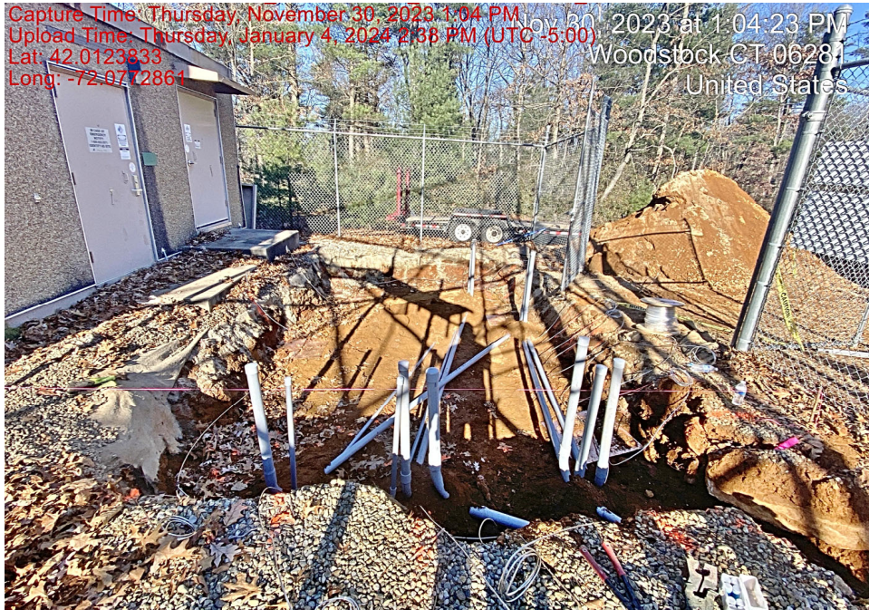
New conduit installation
