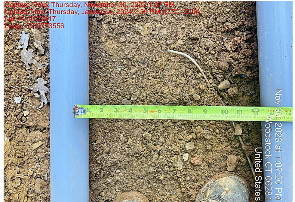
New conduit installation - conduit spacing
