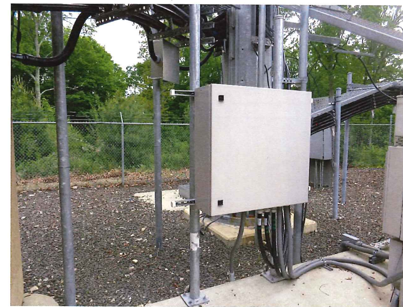
4 EXIST FIBER DISTRIBUTION BOX A-3 SCALE: N.T.S.
