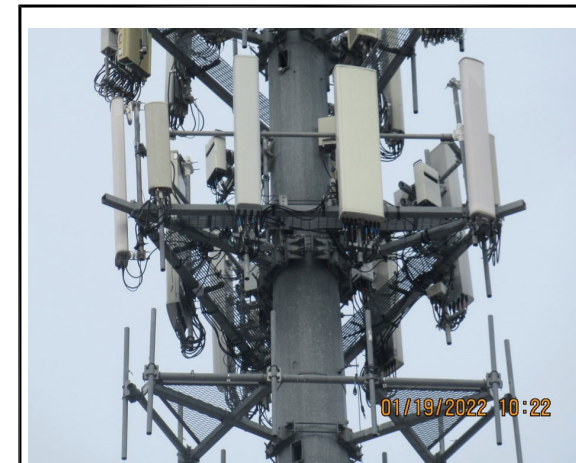
SITE PHOTO 1 SCALE: N.T.S. 2
