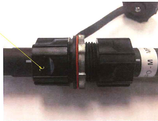
1 HYBRIFLEX RISER/JUMPER CONNECTION DETAILS A-6 SCALE: N.T.S.
