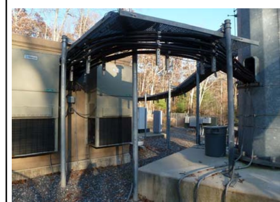
SITE PHOTO 2 SCALE: N.T.S. 3
