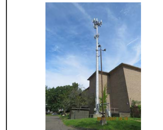
SITE PHOTO 2 SCALE: N.T.S. 3
