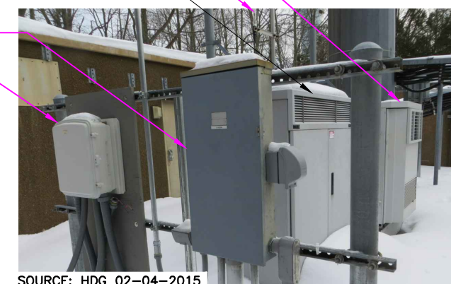
EXISTING EQUIPMENT PHOTO DETAIL (3 A-1) SCALE: N.T.S.
