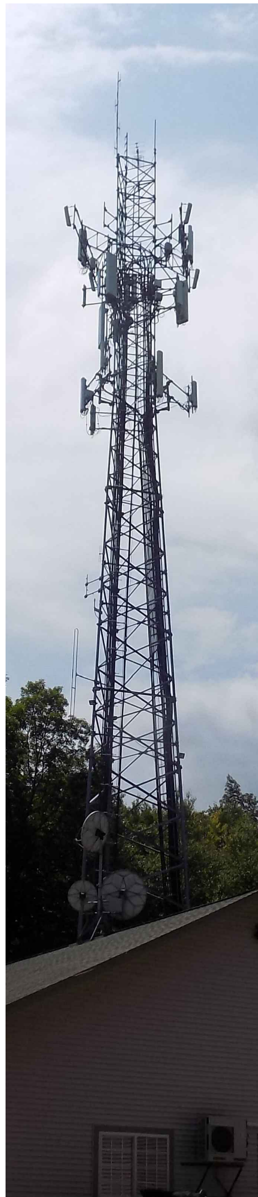
EXISTING TOWER PHOTO SCALE: N.T.S.
