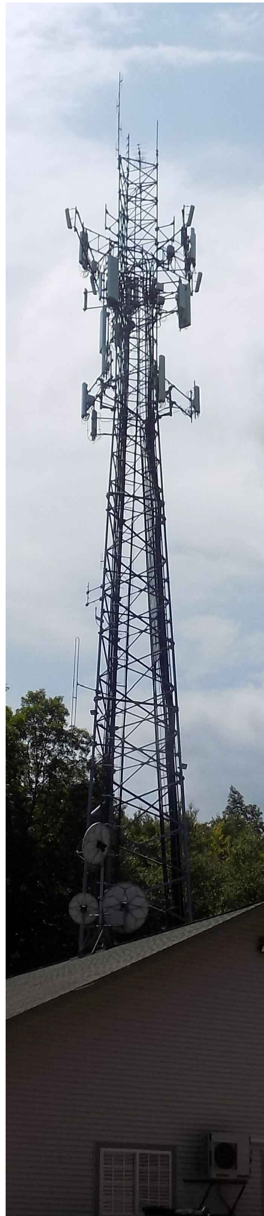
EXISTING TOWER PHOTO SCALE: N.T.S.
