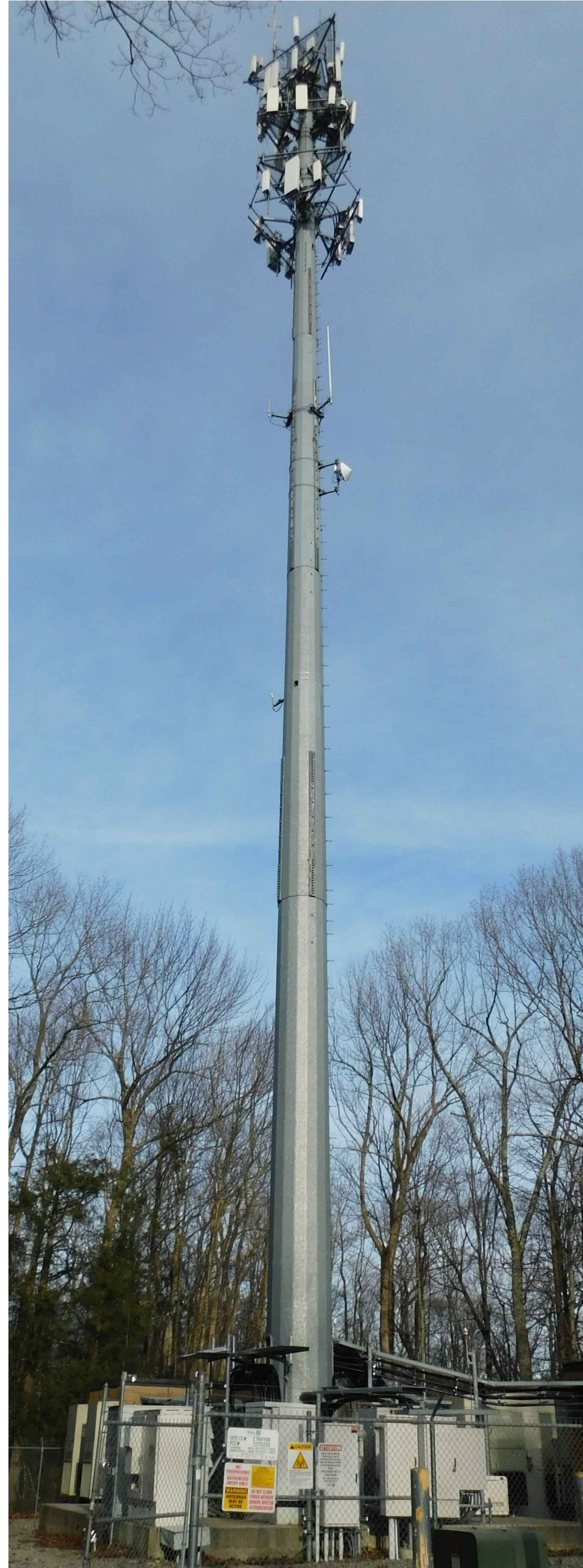
EXISTING TOWER PHOTO SCALE: N.T.S.
