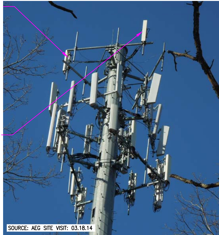
1 A-3 EXISTING ANTENNA MOUNT TYP. N.T.S.
