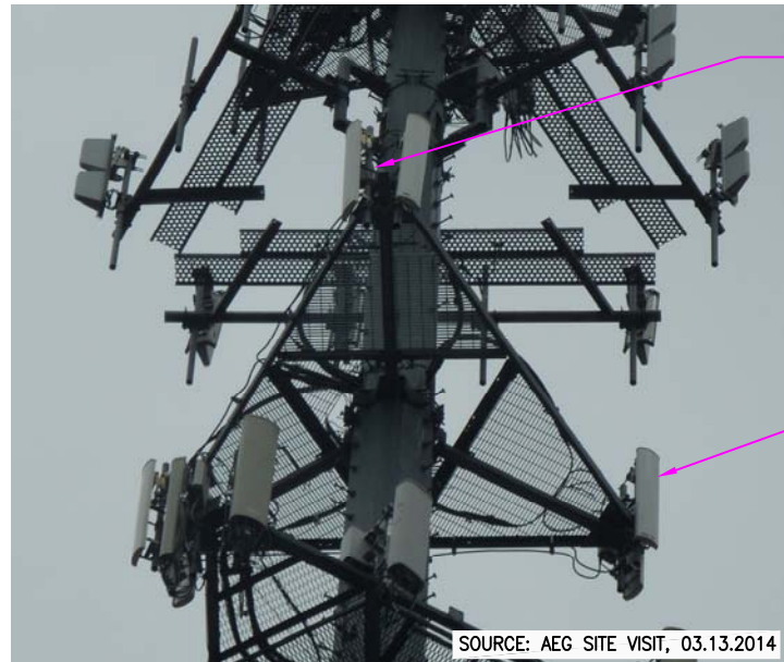
1 A-3 EXISTING ANTENNA MOUNT TYP. N.T.S.
