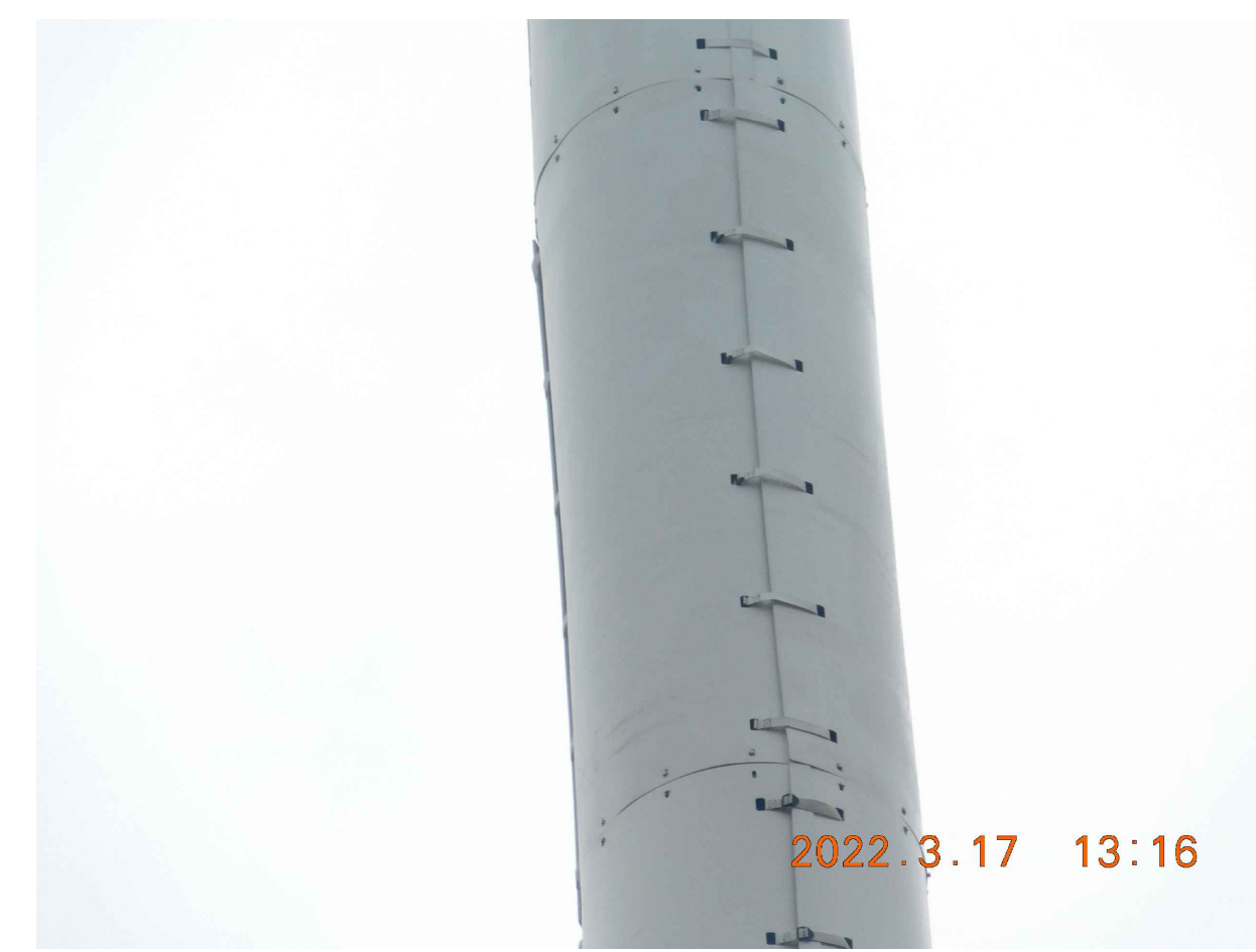
EXISTING ANTENNA PHOTO 3 SCALE: N.T.S. A-2
