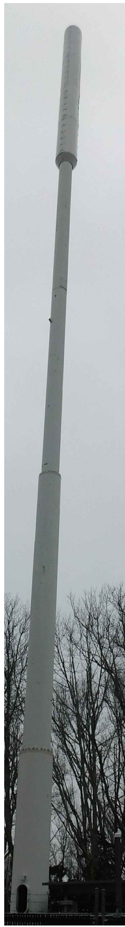
EXISTING TOWER PHOTO 1 SCALE: N.T.S. A-2
