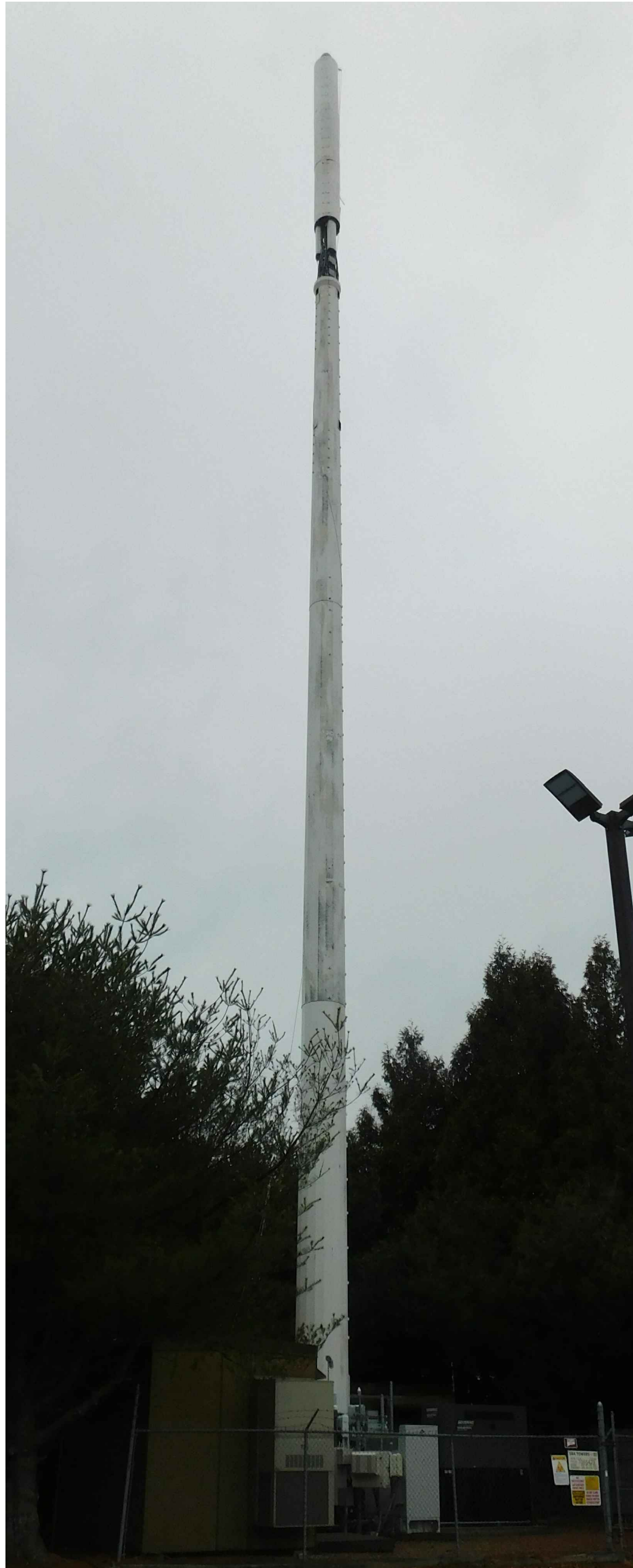
EXISTING TOWER PHOTO SCALE: N.T.S.
