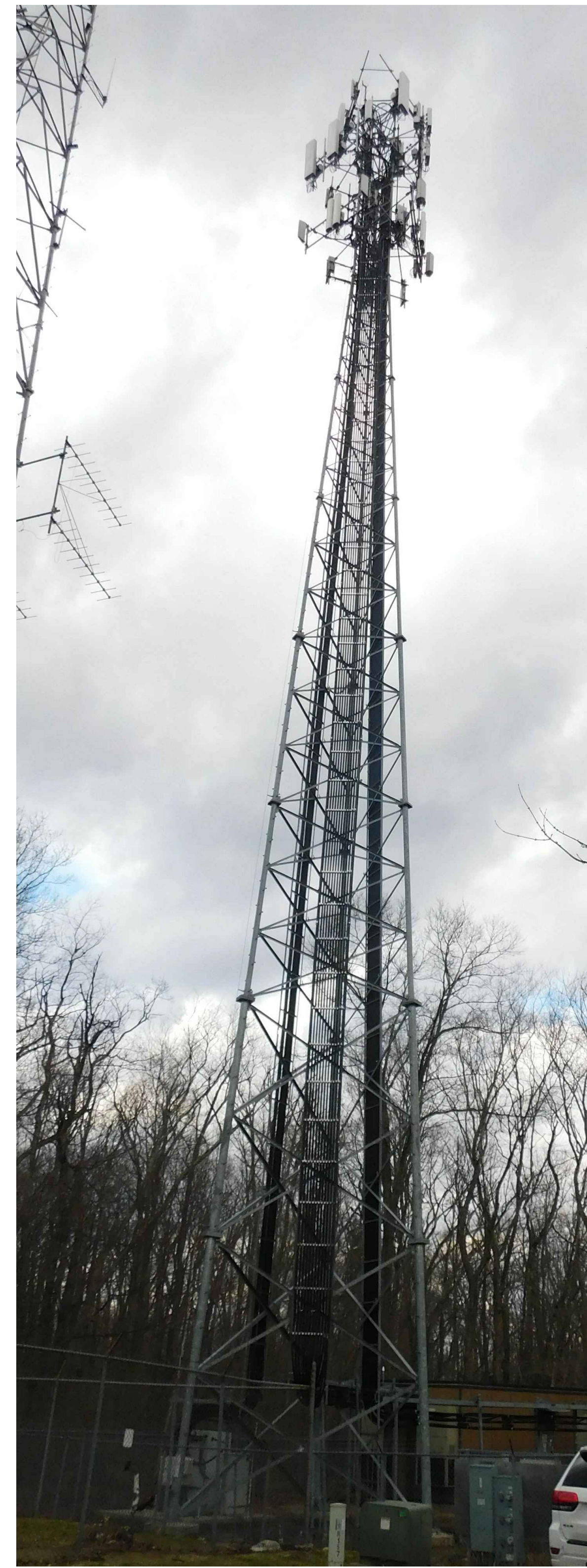
EXISTING TOWER PHOTO SCALE: N.T.S.
