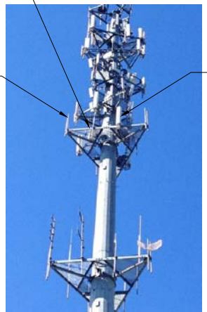
EXISTING PARTIAL ELEVATION PHOTO DETAIL SCALE: N.T.S.
