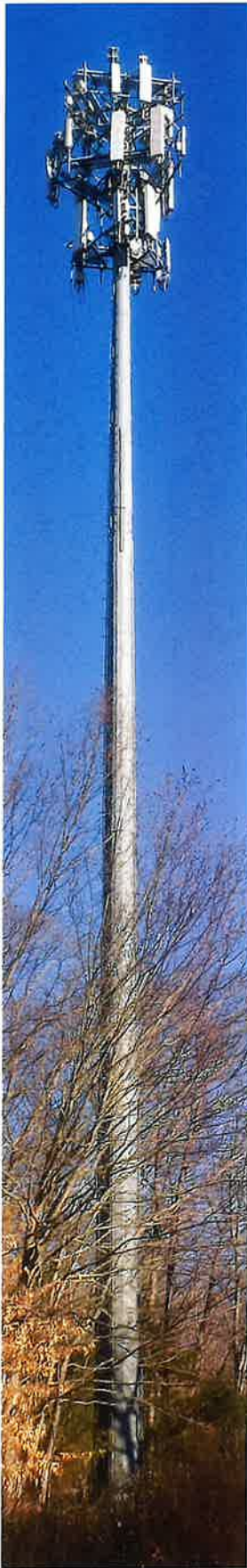
EXISTING TOWER PHOTO SCALE: N.T.S.
