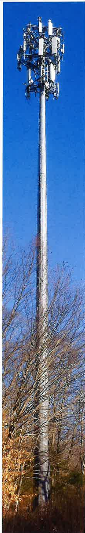
EXISTING TOWER PHOTO SCALE: N.T.S.
