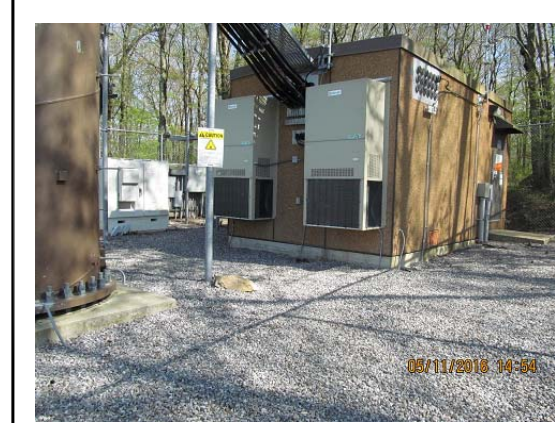
SITE PHOTO 2 SCALE: N.T.S. 3
