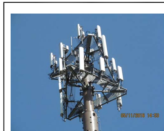
SITE PHOTO 1 SCALE: N.T.S. 2
