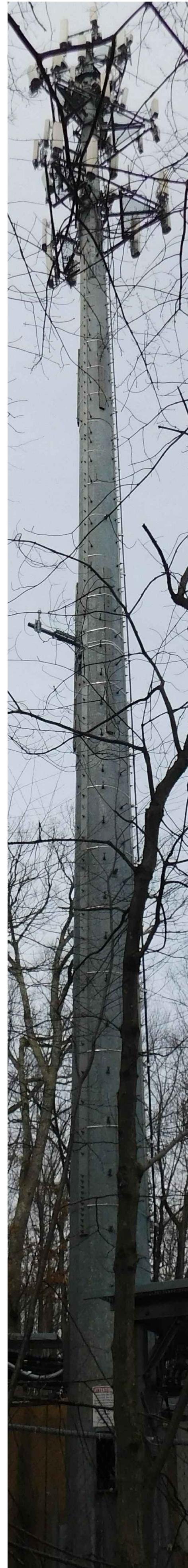
EXISTING TOWER PHOTO N.T.S. 1 A-2
