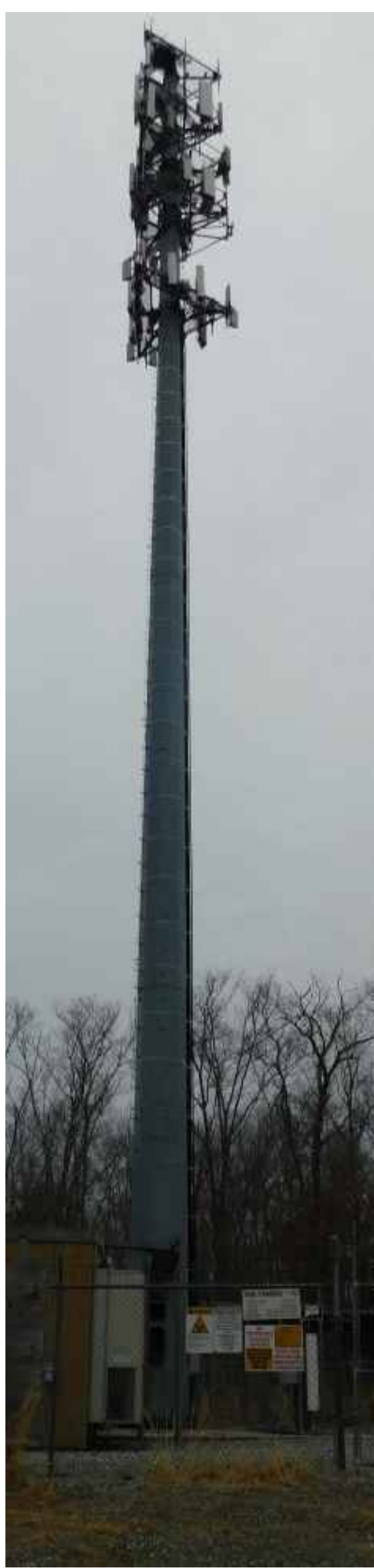
EXISTING TOWER PHOTO SCALE: N.T.S.
