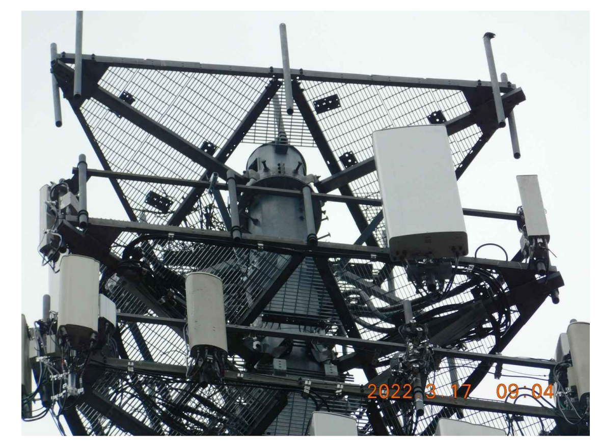
EXISTING TOWER PHOTO SCALE: N.T.S.
