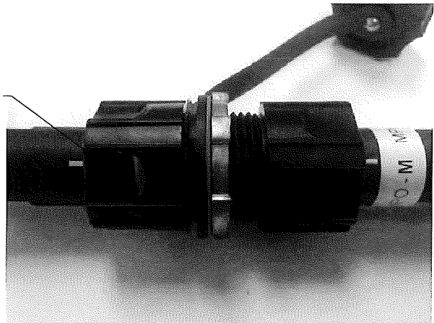
1 HYBRIFLEX RISER/JUMPER CONNECTION DETAILS A-6 SCALE: N.T.S.
