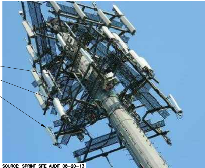
EXISTING PARTIAL ELEVATION PHOTO DETAIL SCALE: N.T.S.
