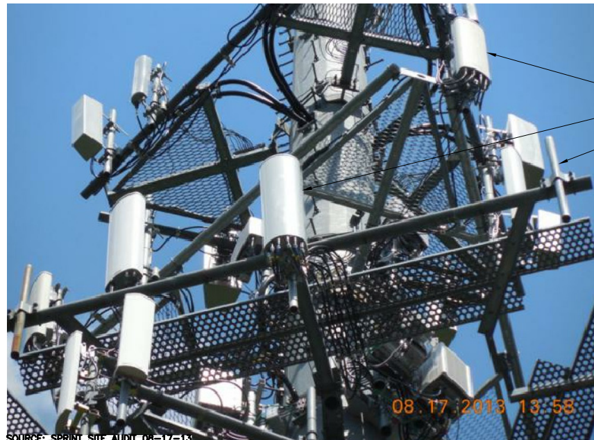
EXISTING PARTIAL ELEVATION PHOTO DETAIL SCALE: N.T.S.
